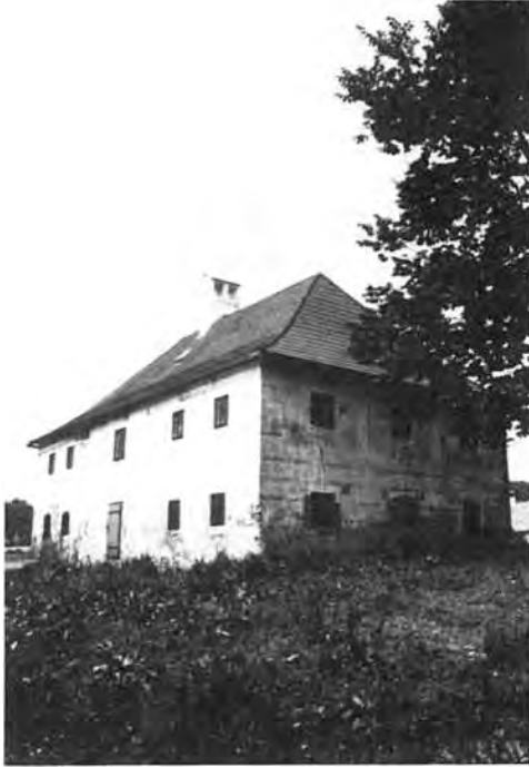
Abb. 145: „Spital“, ehemals Versorgungshaus; im Zentrum zwei Rauchküchen
