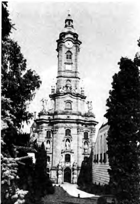
Abb. 179: Die hochbarocke Fassade, von Matthias Steindl entworfen und von Josef Munggenast bis 1727 ausgeführt, zählt zu den Wahrzeichen des Waldviertels
