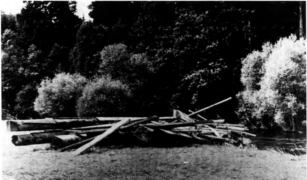
Abb. 204: Das Ende der Oberhofer Holzbrücke in der Ochselweid nach dem Hochwasser am 12./13. August 1959
