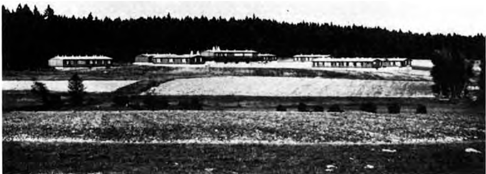
Abb. 82: Ritzmannshof, einstiges Lager des RAD (Reichsarbeitsdienstes)
