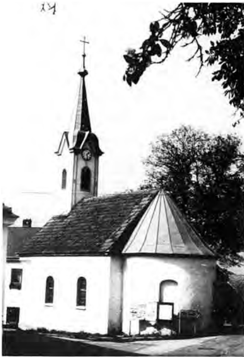
Abb. 192: Die Kapelle des hl. Leonhard in Rudmanns wurde 1725 errichtet
