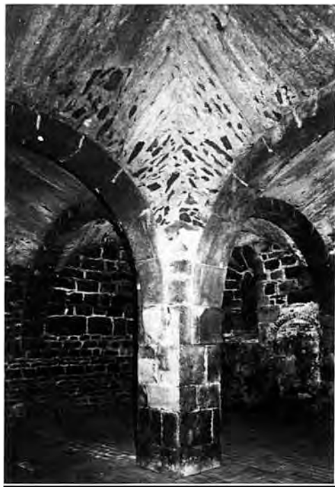
Abb. 174: Der „Untere Einstützenraum“ entstand um 1140/45. Auf dem schlichten, aber wuchtigen Quaderpfeiler ruhen vier Gurtbögen
