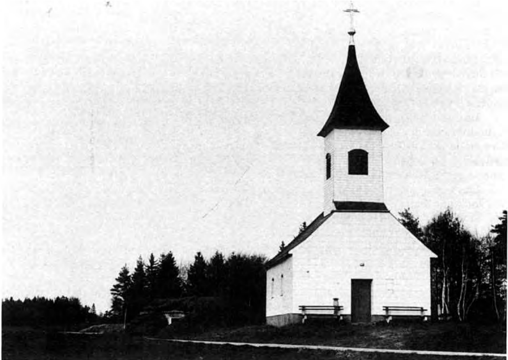
Abb. 169: Kapelle Unterrosenauerwald. Um 1800 erbaut und 1971 gründlich renoviert
