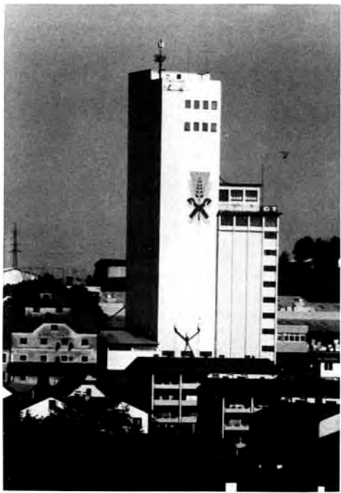
Abb. 14: Altes Lagerhausgebäude mit Silotürmen
