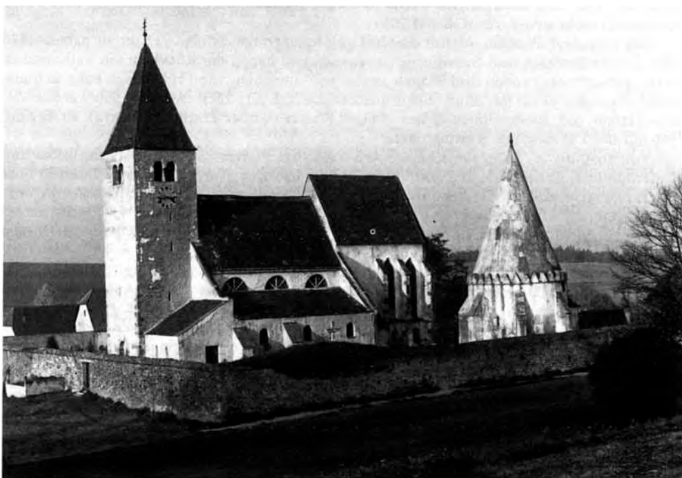
Abb. 43: Pfarrkirche und Karner von Friedersbach von SW
