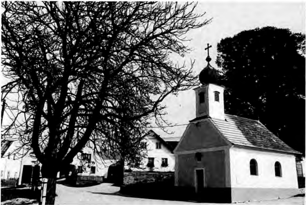
Abb. 198: Kapelle in Kleinschönau, um 1830 erbaut
