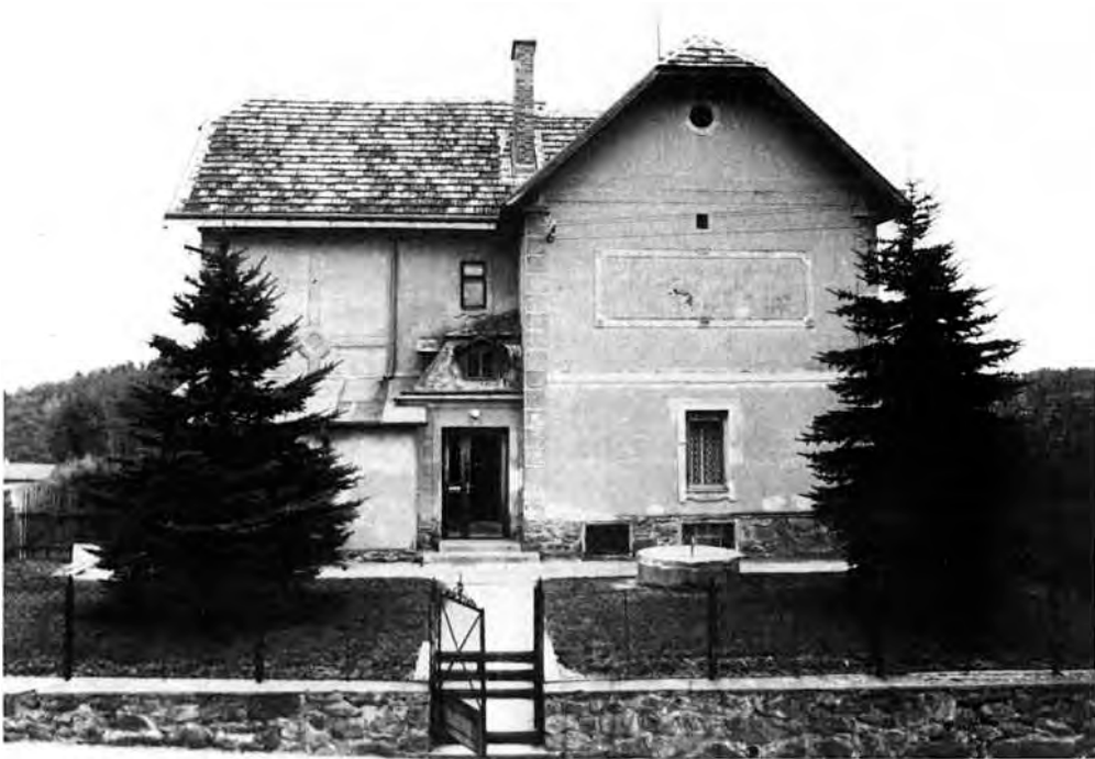
Abb. 93: Volksschule in Jahrgs vor ihrer Renovierung 1982
