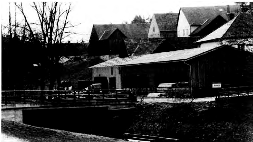
Abb. 235: Das neue, alte Sägewerk an der Zwettl
