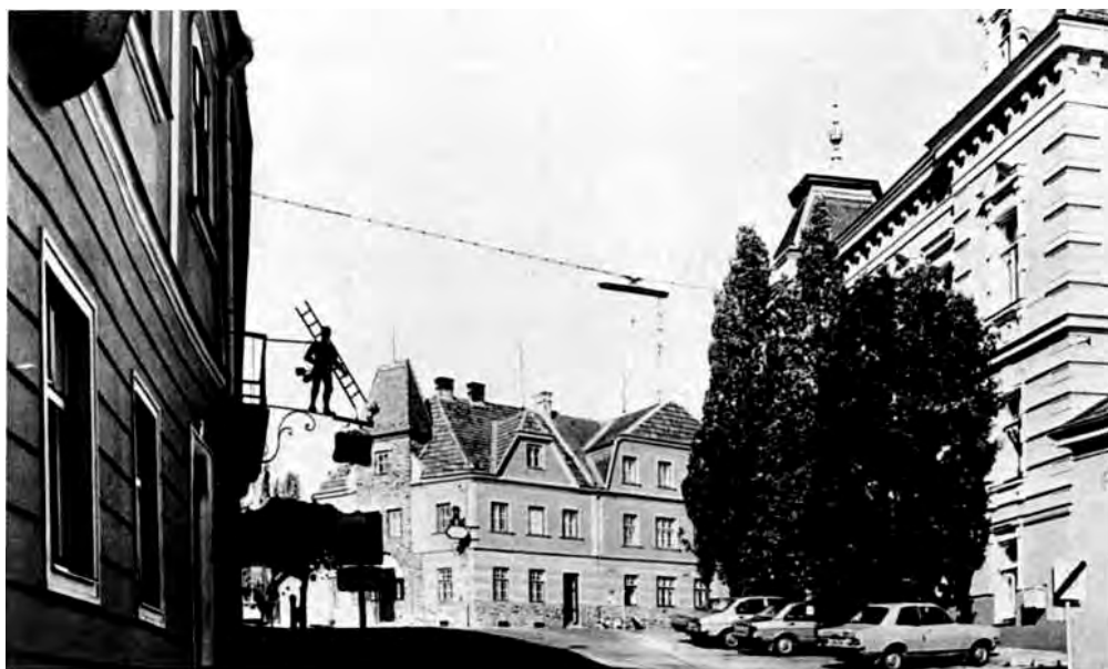
Abb. 160. Die Landstraße beim ehemaligen Oberen Tor
