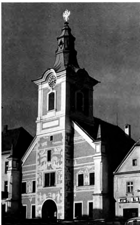
Abb. 77. Das alte Rathaus ist einer der ältesten Profanbauten der Stadt. Es musste jedoch im Laufe der Jahrhunderte öfters umgebaut und verändert werden. Die fragmentarisch erhaltenen Sgraffiti stammen aus 1549/50 und wurden 1978 restauriert
