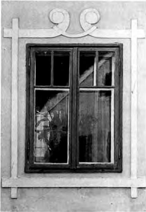
Abb. 94. Um die Fenster des Hauses Oberhof 16 sind schlichte Banddekorationen aus der Zeit des Jugendstiles angebracht
