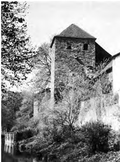
Abb. 70. Der quadratische „Hofbauerturm“ steht am oberen Drittel der Westflanke der Stadtmauer.
