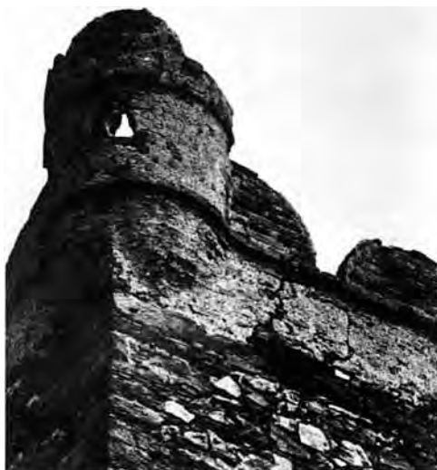
Abb. 71. Den rechteckigen Mauervorsprung an der Westflanke der Stadtmauer bekrönen Zierzinnen und „Pfefferbüchsen“ aus der Renaissancezeit
