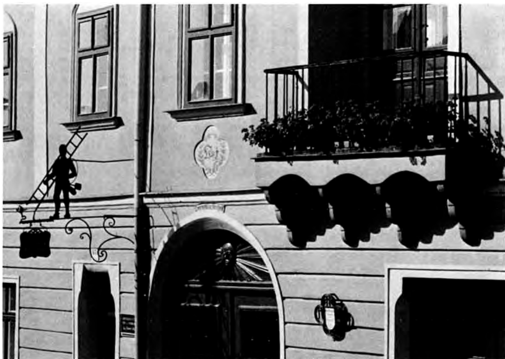
Abb. 80. Ein sehr altes und interessantes Haus ist der Pernerstorferhof. Auch er wurde oft umgebaut. Aus gotischer Zeit stammen vier Kragsteine, die ursprünglich einen Erker getragen haben. Die Fassadierung ist barock
