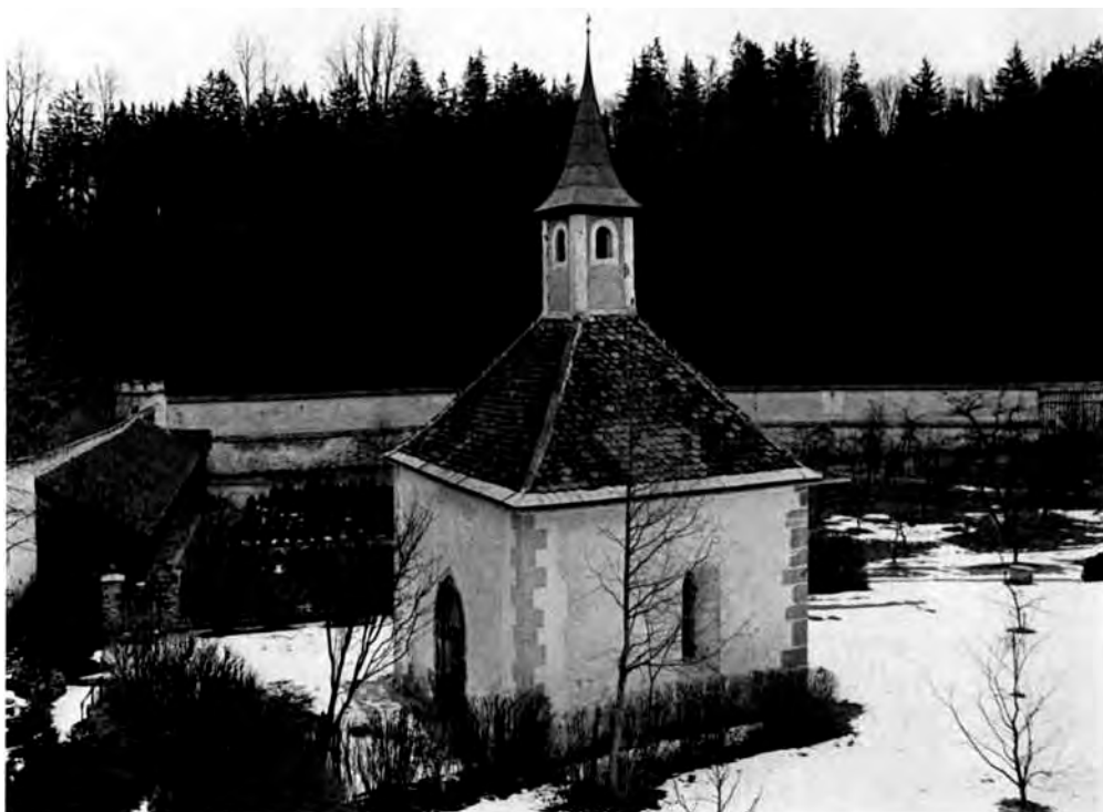
Abb. 138. Romanische Kapelle — Rest des ersten Spitalbaus (1194) in Stift Zwettl
