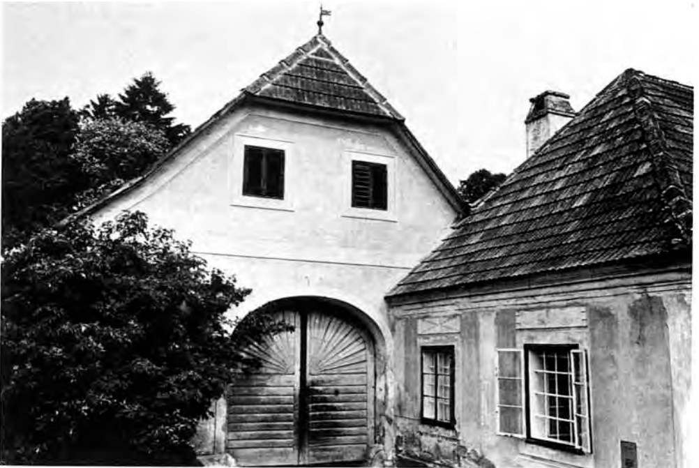
Abb. 85. Wohn- und Wirtschaftsgebäude sind beim Haus Klosterstraße 21 im rechten Winkel zueinander angeordnet. Die Überschneidung beider Bauteile ergibt ein recht malerisches Bild
