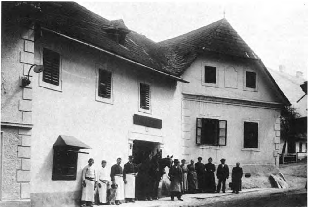
Abb. 188. Die Fleischhauerei Brandner (Kremser Straße 3) vor dem Umbau
