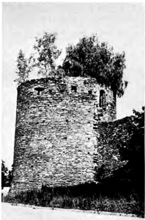
Abb. 67 Der „Sattigturm“ an der Nordostecke der Stadtmauer hat einen kreisförmigen Grundriss
