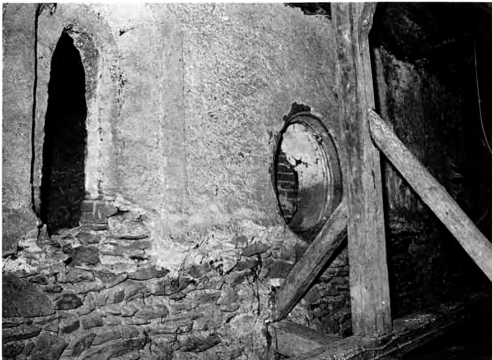
Abb. 82. Die Baugeschichte der in der 1. Hälfte des 13. Jahrhunderts als Pfeilerbasilika errichteten Stadtkirche lässt sich heute auf dem Dachboden über den Seitenschiffen gut verfolgen. Das Mittelschiff überragte die ursprünglichen Pultdächer der Seitenschiffe und besaß romanische Trichterfenster. Nach dem Einbau des gotischen Gewölbes wurden diese durch Rundfenster ersetzt. Erst 1681/82 wurden die drei Schiffe durch ein großes Satteldach zusammengefasst
