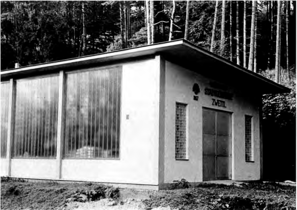
Abb. 29. Aufbereitungsanlage der Hochbehälterwasserleitung 1967
