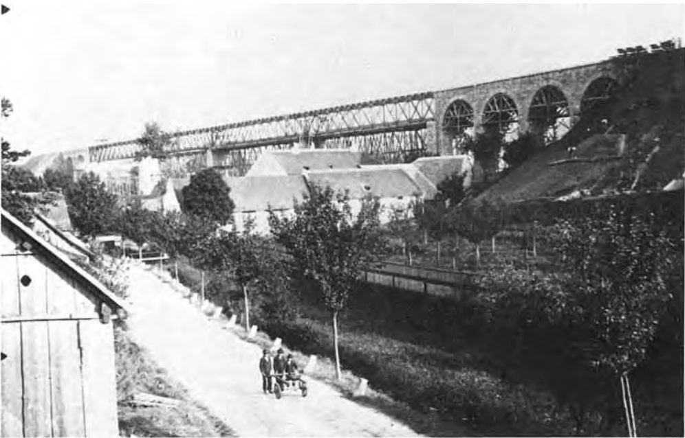
Abb. 192. ... und Bahnbrücke (1905/06) gebaut wurden
