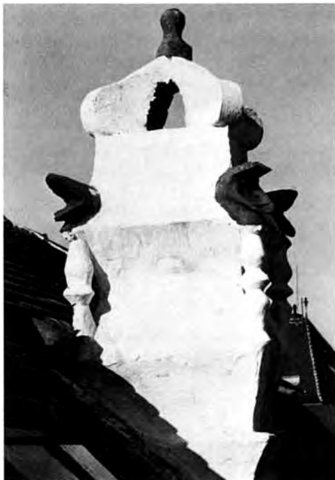
Abb. 73. Eine Kostbarkeit ist der Renaissance-rauchfang des Hauses Hauptplatz 11
